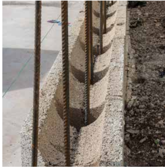
Figura 2: Cómo colocar la primera hilera de Blocks Bautex
