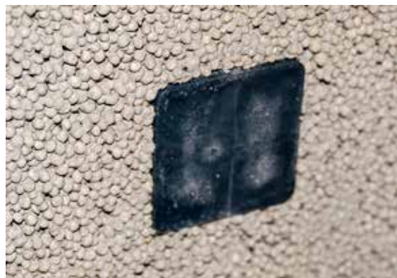
Figura 10: Instalación de Anclaje de muro Bautex
