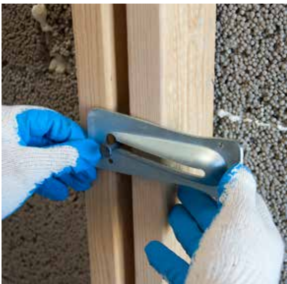
Figura 9: Instalación de tirante de resorte, cuñas y cimbra
