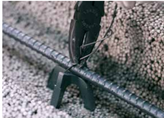
Figura 7: Cómo amarrar el refuerzo al soporte de varilla
