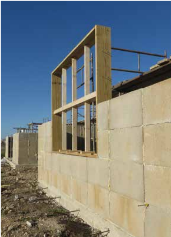
Figura 13: Preparación para ventana de madera fija
