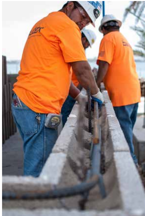
Figura 5: Colocación de acero de refuerzo horizontal
