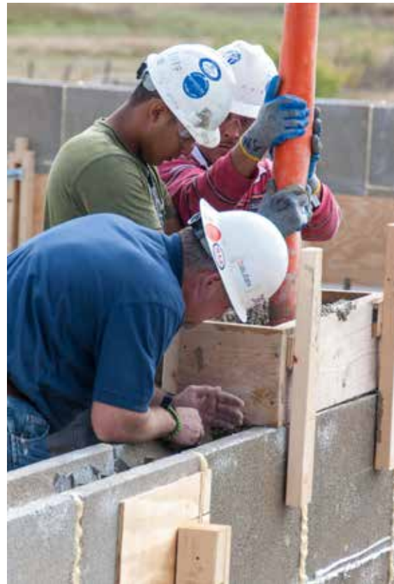
Figura 17: Vaciado de muro usando camisa de kevlar y caja de vaciado
