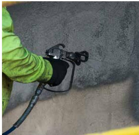
Figura 19: Aplicación de barrera contra humedad y aire
