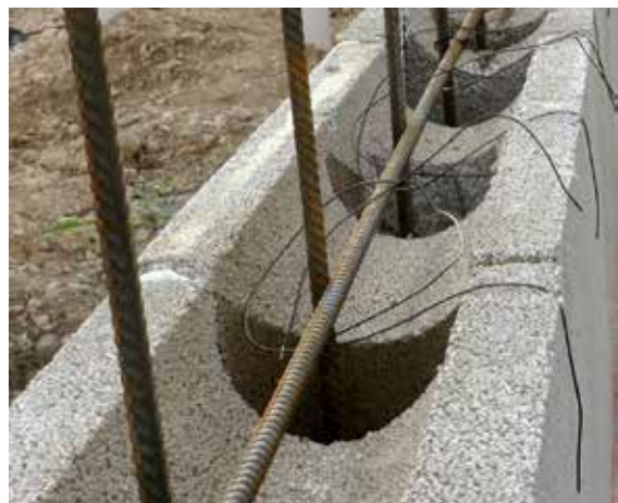
Figura 8: Lazos para amarres de refuerzo vertical
