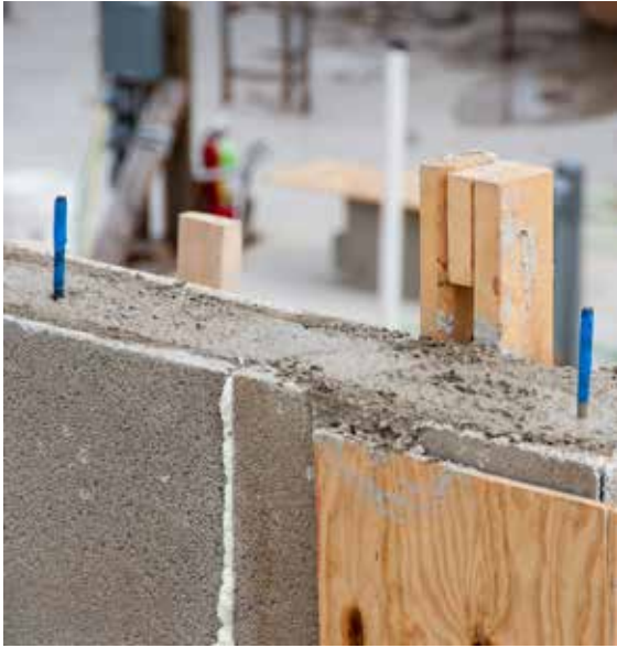
Figura 15: Colocación en húmedo de pernos-J para placa superior de muro
