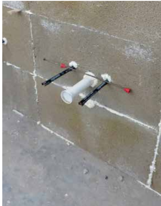
Figura 18: Artículos mecánicos instalados en el muro Bautex
