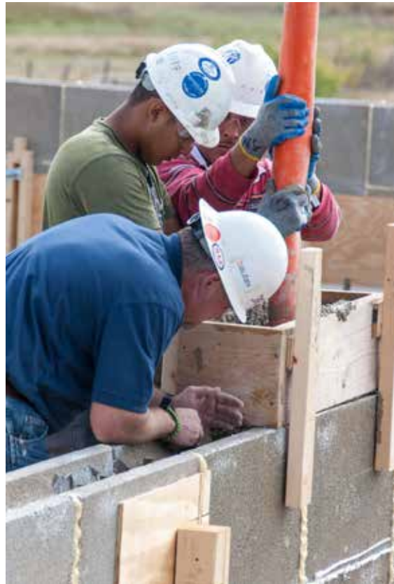
Figure 17: Wall pour using kevlar sleeve and pour box
